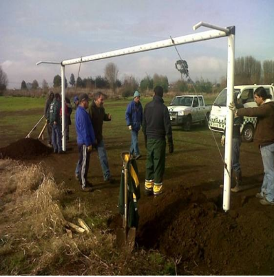
Instalan arcos de fútbol en parque estadio de Labranza
